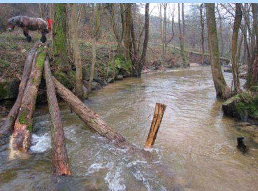
En photo sur la première page: Implantation de pré-barrage franchissable en rondins sur l'Yzeron, les fournitures sont prises sur place à moins de 200 mètres du site des ouvrages.
